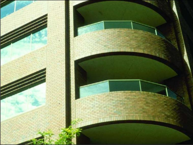
L'utilisation de la « brique mince » est devenue populaire dans l'application en façade des panneaux préfabriqués en utilisant une brique de 41 mm avec un dos cannelé pour favoriser son lien avec le béton; toutefois, l'utilisation de demi-briques demeure la méthode la plus communément utilisée. On peut également utiliser des briques de dimension conventionnelle maintenues en place par des attaches.
