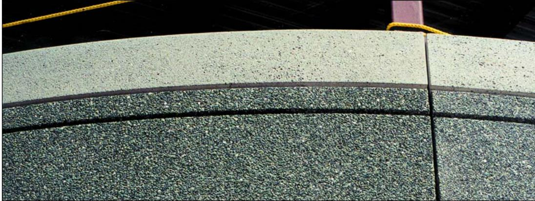
Ensuite, la surface ne doit pas comporter d'imperfections autres que des variations minimales dans la couleur et la texture, ni ne laisser voir des réparations lorsque observée sous les conditions de lumière prévues, à l'œil nu et à une distance de six mètres. L'apparence de la surface ne devrait pas être évaluée lorsque le soleil illumine la surface suivant un angle extrême, puisque même les irrégularités mineures de la surface sont alors accentuées.
