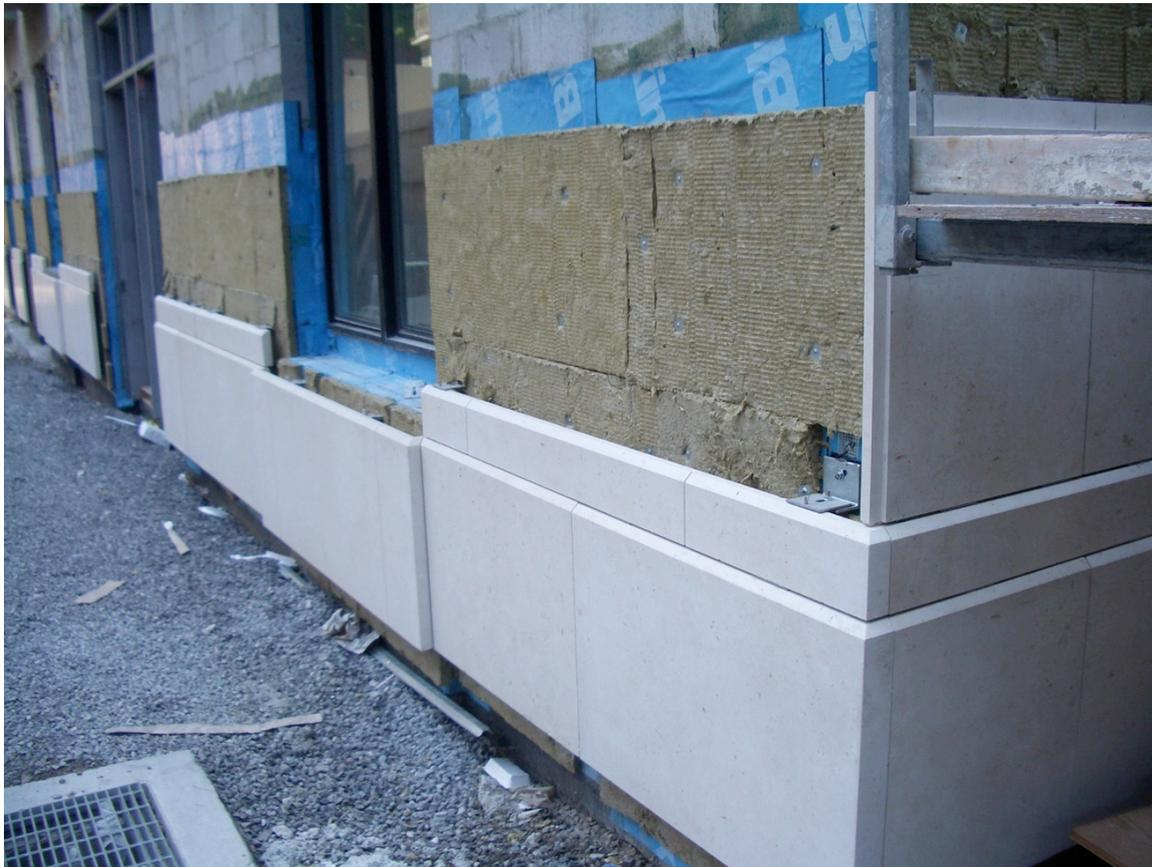
**Figure 4: agencement de pièces de béton préfabriqué de petit format installées en système drainé**
