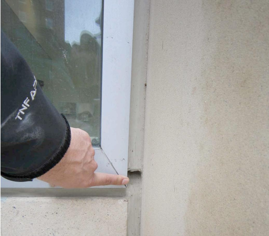
**Figure 18: Chantepleur dans un joint drainé en deux étapes**
