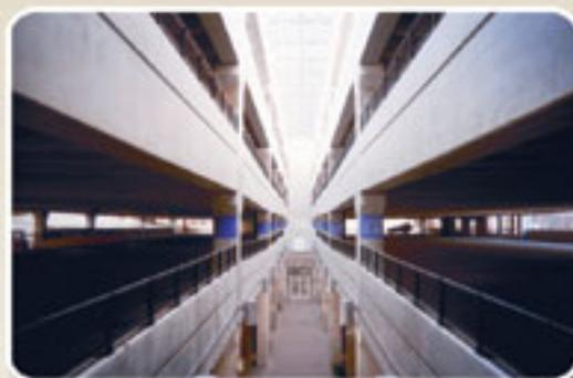
**Qualité de construction:** Le risque de fissures augmente sur les éléments des stationnements en béton coulé en place. L'ossature des stationnements étagés de SCHOKBETON est faite d'éléments coulés dans des moules lisses en acier, et résiste mieux aux intempéries.
