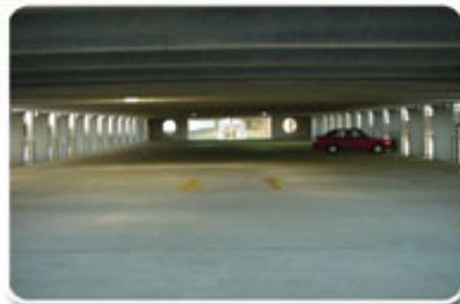
**Encombrement réduit:** Les accrochages entre les véhicules et les nombreuses colonnes des stationnements faits de béton coulé en place sont trop courants. Grâce à ses longues portées, le système de stationnement étagé de SCHOKBETON garantit plus d'espaces et plus de sécurité aux usagers.
